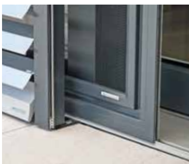
Odsazená vodící lišta pro posuvnou sít' proti hmyzu
